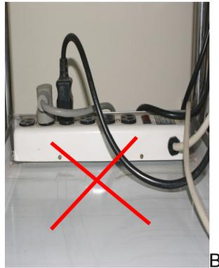
圖 2-17 注意用電安全，應使用獨立插頭，避免使用延長線。
